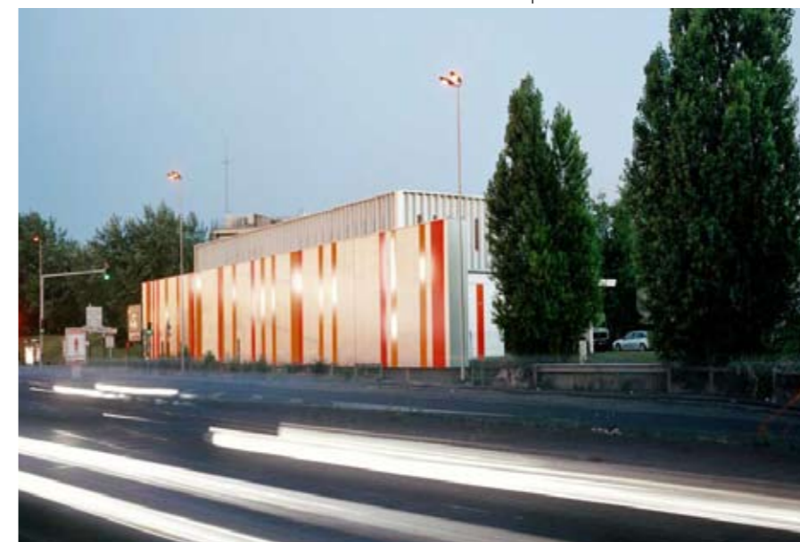
Pôle de sécurité routière à Rosny Maître d'ouvrage : DDE Seine St Denis Maître d'oeuvre : BP Architecture (membre de PLAN01) avec MTC Surface Utile : 780 m 2 Coût : 1,4 M € HT Livraison : 2008
