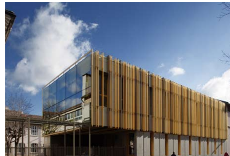
Double extension d'école A Courbevoie Maître d'ouvrage : Ville de Courbevoie Maître d'oeuvre : BP Architecture (membre de PLAN01) avec MTC - DAL Surface Utile : 2 200 m 2 Coût : 3,2 M € HT Livraison : septembre 2008
